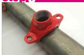
Aprire la presa a staffa, appoggiare la parte superiore della presa sul foro della tubazione, posizionando correttamente la guarnizione.
