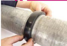
Appoggiare l'estremità della seconda tubazione alla prima e far scorrere la guarnizione sino a che non si trovi appoggiata su entrambe le tubazioni; centrare la guarnizione tra le due scanalature sull'estremità dei 2 tubi.
