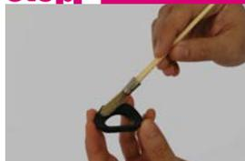
Infilare la guarnizione in un'estremità della prima tubazione, facendola scorrere sino ad arrivare al bordo della tubazione stessa.
