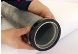
Infilare la guarnizione in un'estremità della prima tubazione, facendola scorrere sino ad arrivare al bordo della tubazione stessa.
