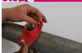
Aprire la derivazione a staffa, appoggiare la parte superiore della derivazione sul foro della tubazione, posizionando correttamente la guarnizione.
